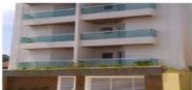
Construções de Prédios
