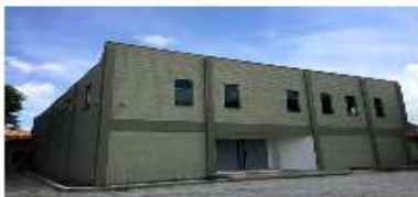
Construção de Galpão Comercial
