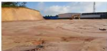
Serviços de Terraplenagem
